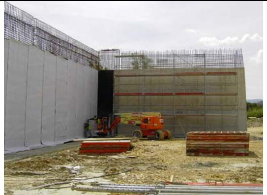
IMPERMEABILIZACION EN TRASDOS DE MURO (TRAMO AUTOVIA A-7)
