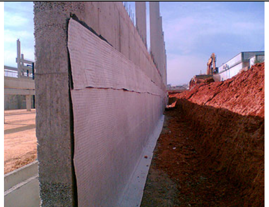
IMPERMEABILIZACION EN TRASDOS DE MURO
